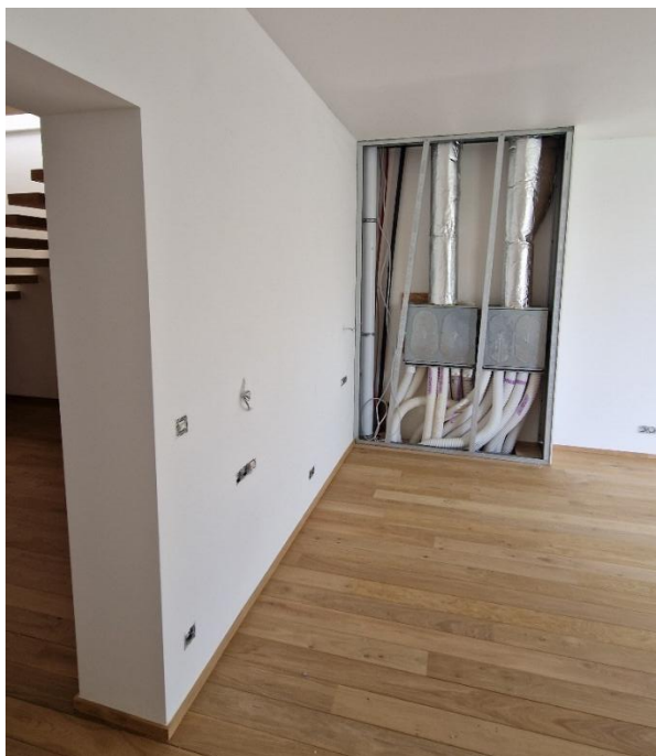
Photo 12 : Vue sur la gaine technique qui traverse la chambre arrière du 2 ème étage
